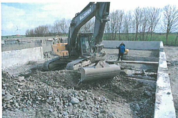
Verfüllung mit dem auf „faustgroßes“ Betonrecycling zerkleinertes Abbruchgut
