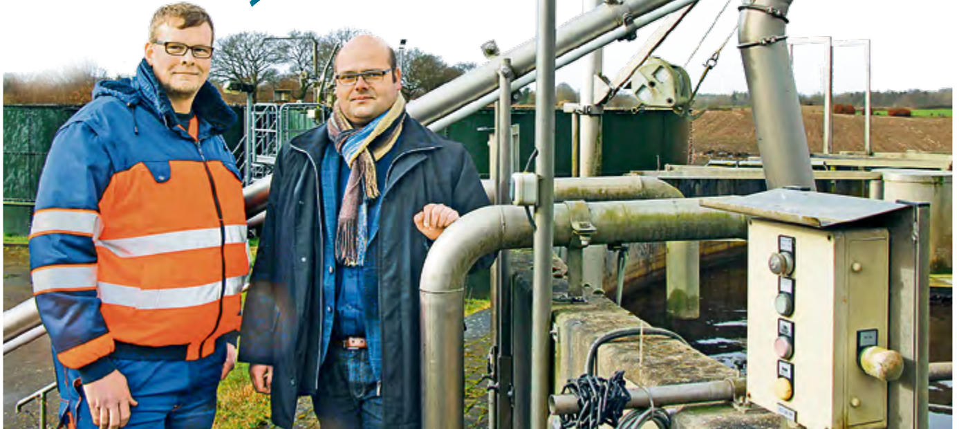
Bürgermeister Finn Petersen (re.) im Gespräch mit Abwasserfachmann Sören Leng auf der Kläranlage Sieverstedt.
