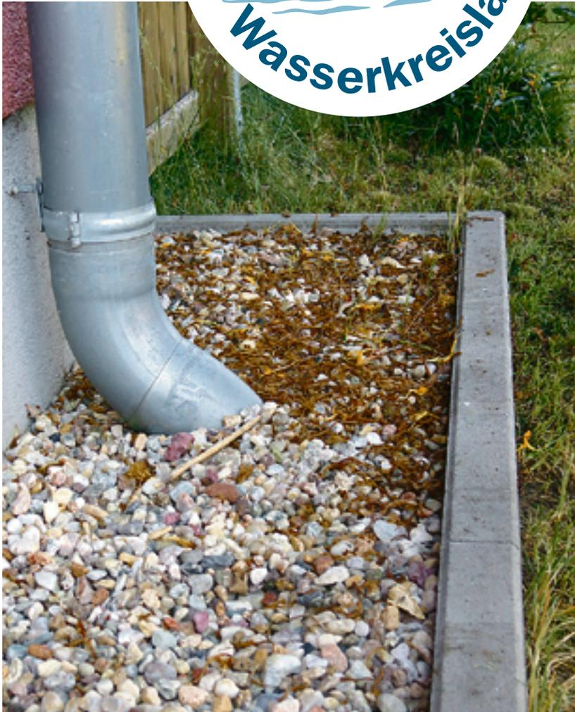
Bei Starkregen fallen schnell 30 bis 50 Liter Niederschlag pro Quadratmeter. Das bedeutet, dass von einem durchschnittlichen Dach mit 100m<sup>2</sup> Fläche bis zu 5.000 Liter Wasser entsorgt werden müssen. Die sollten von der Dachrinne nicht einfach auf den Boden rauschen. Die Gefahr einer Überflutung des Gartens wäre groß. **Am besten führen Sie die Regenrinne ...**
