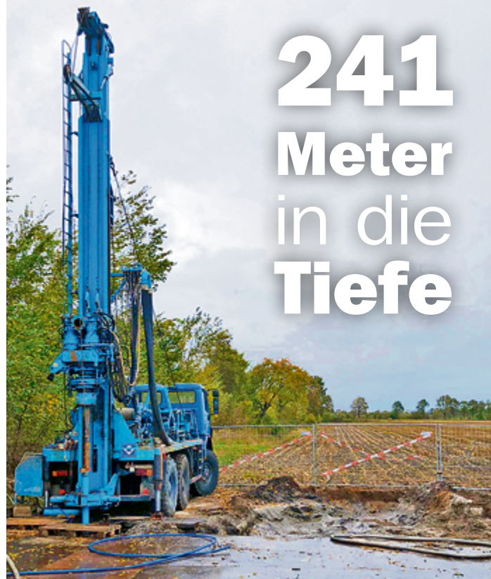
Stück für Stück bahnte sich der Bohrer am Brunnenfeld den Weg frei um bis zum Grundwasser zu kommen.
