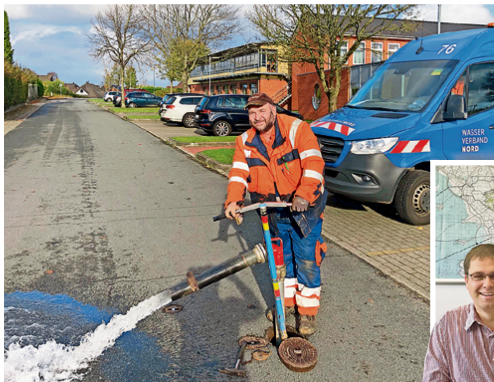
▲ Rohrnetzmitarbeiter Jos Tams spült die Leitungen im Handewitter Ortsteil Weding.
