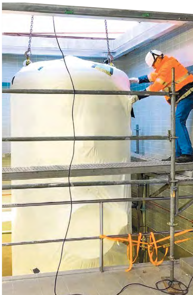
Knappe Kiste: Durch das Dach wurden die neuen Druckwindkessel „eingeflogen“ und passgenau platziert.
