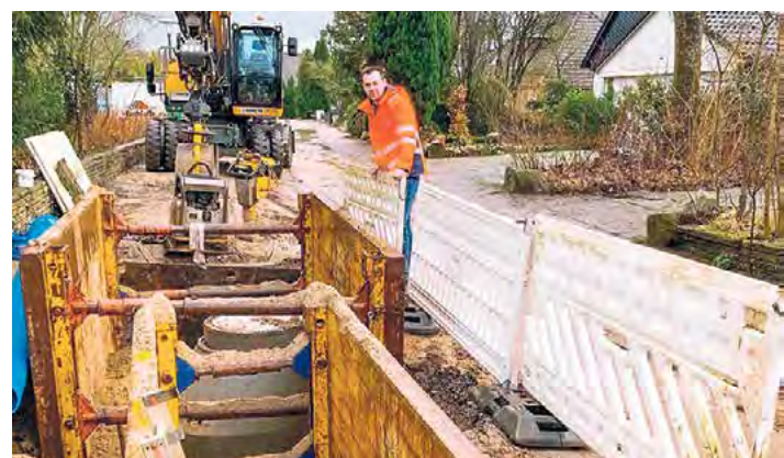
Etwas Baufreiheit ist nötig für die Arbeiten zur Erneuerung des Niederschlagskanals am Wehlberg in Oeversee.
