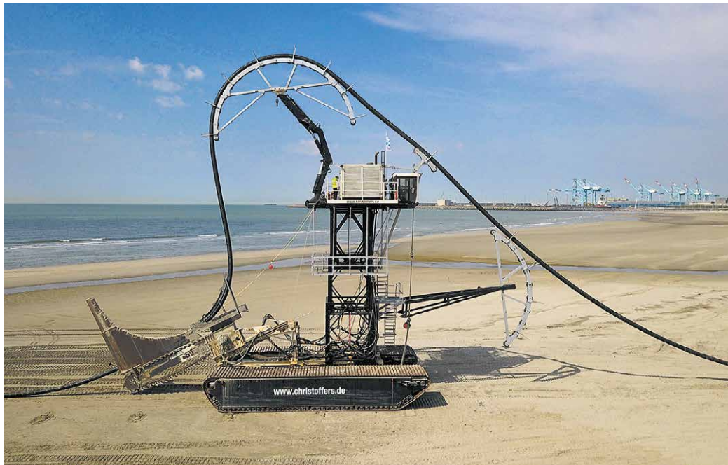
Liebevoll „Nessi“ bezeichnet, kommt diese riesige Verlegeeinheit zum Einsatz im Watt. Der Arbeiter in gelber Jacke auf der Plattform in der Mitte verdeutlicht die Größe des besonderen Gefährtes.
