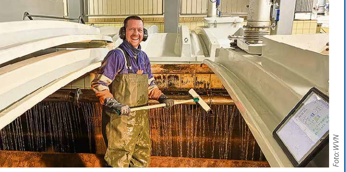
Markus Panna befreit die Düsen im Filter von Eisenablagerungen.
