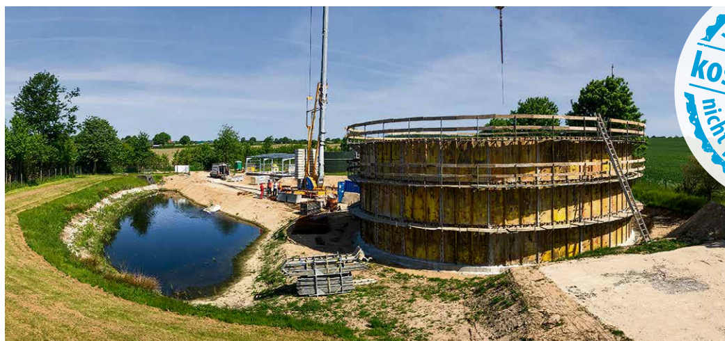
Das Foto von der Baumaßnahme an der Kläranlage Freienwill symbolisiert: Wer Abwasser sicher reinigen will, muss Netze und Anlagen pflegen, warten, sanieren, erneuern. Die Kundinnen und Kunden zahlen hierfür – je nach örtlichen Bedingungen – Abwassergebühren.
