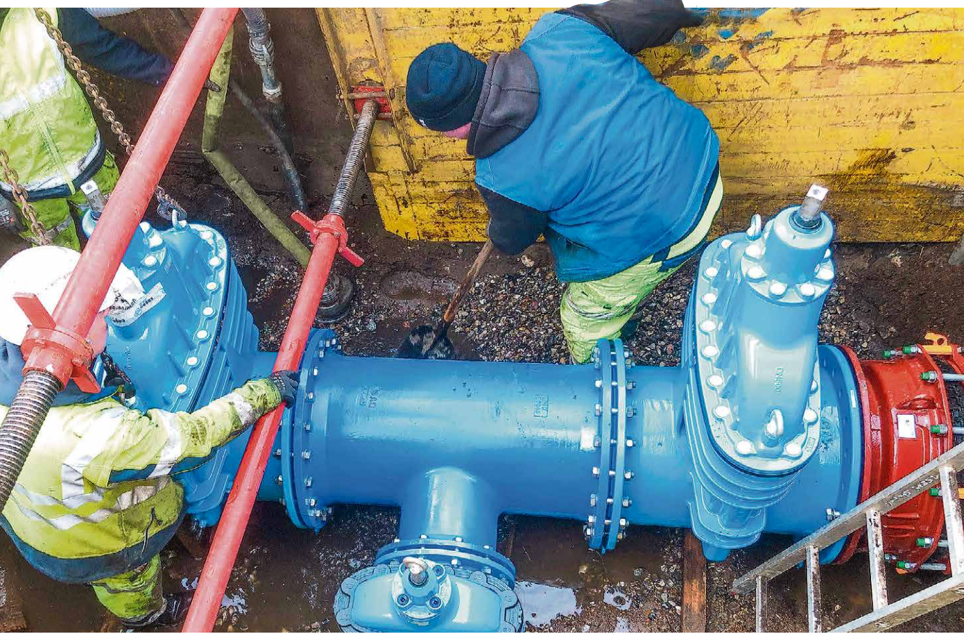
Eine neue Haupttransportleitung soll Trinkwasser in den Norden bringen. Im Herbst 2025 wurde in Vorbereitung schon ein Schieberkreuz in der Nähe des Wasserwerks in die Erde gebracht.
