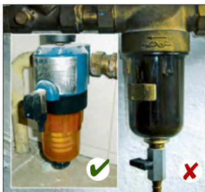
Links der Filter, wie er ordentlich gewartet aussehen sollte, und rechts der unerwünschte Zustand. Foto: SPREE-PR/Archiv
