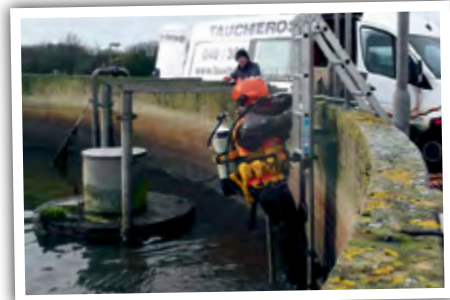
Im vorhandenen Reaktor demontieren Taucher die benötigten Armaturen im Becken.
