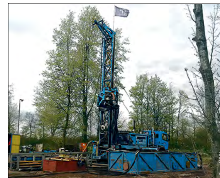
Im Vergleich zu seinem tiefsten „Kollegen“, der das Wasser aus 332 Metern emporholt, ist der Neue mit seinen 140 Metern recht flach im Einsatz. Dennoch ist der Brunnen 13 leistungsstark, kann er doch bis zu 130 m 3 Wasser je Stunde fördern, und steht seinen Partnern somit gut zur Seite. 380.000 Euro investierte der WV Nord in diese Baumaßnahme, die der Versorgungssicherheit dient.
