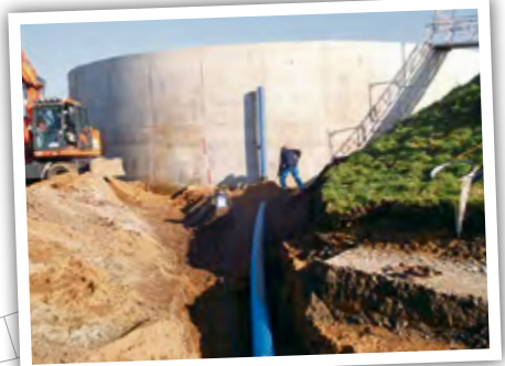
Anfang des Jahres wuchs der Rohbau des neuen Beckens für den zweiten Sequenz-Becken-Reaktor (SBR).
