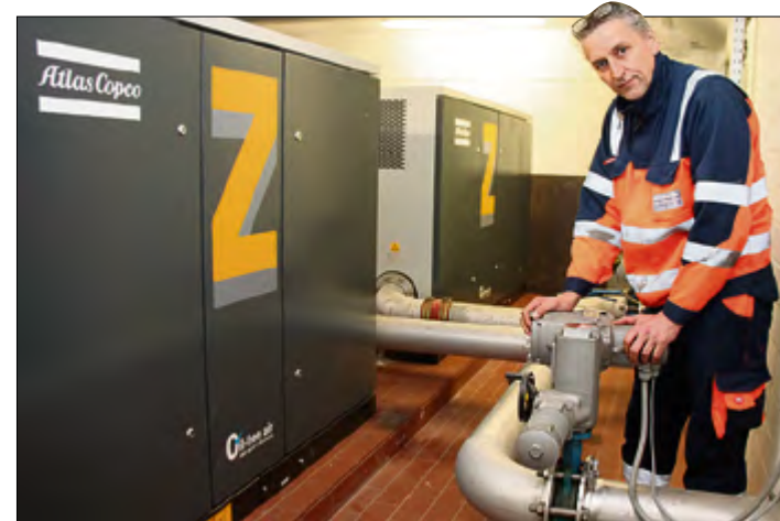
Das Ziel von QMS und EnMS: effizient arbeiten. Abwassermeister Martin Morzik zeigt ein Beispiel aus der Praxis. Auf der Kläranlage Bredstedt investierte der WV Nord in neue Gebläse und verbesserte deren Steuerung. Die Stromkosten reduzieren sich damit um 11.000 Euro pro Jahr.
