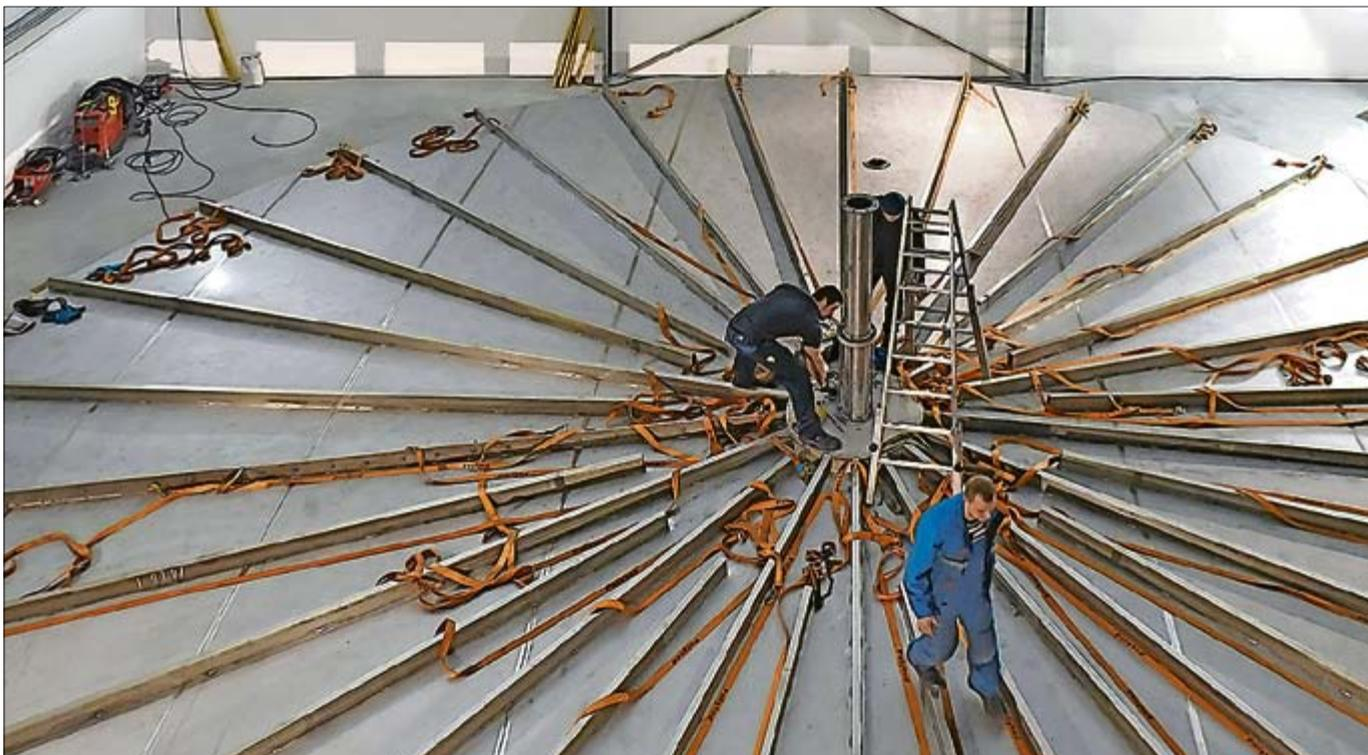
Kein Zirkuszelt. Hier wird das Dach des neuen Stahlbehälters auf das Anschweißen des ersten Rings vorbereitet.
