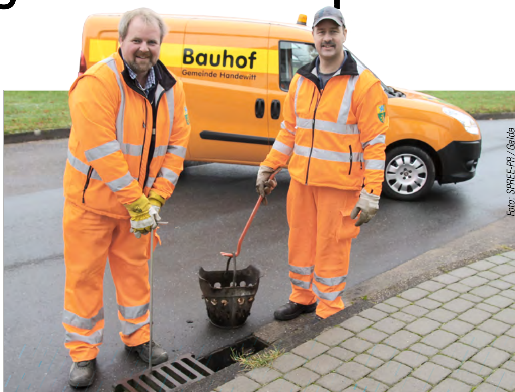
Ulrich Knickrehm (li.) und Dieter Thiesen vom Handewitter Bauhof reinigen die Straßeneinläufe – wichtig, um Rückstau im öffentlichen Schmutzwasserkanal zu vermeiden.
