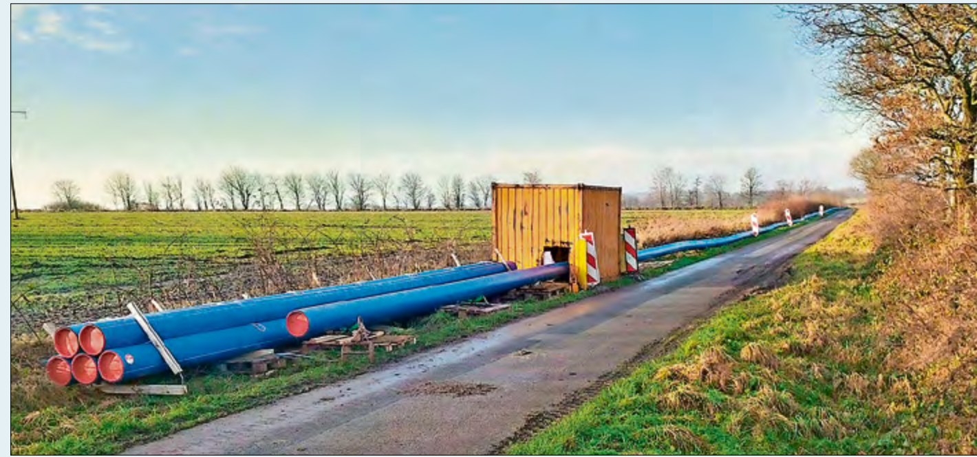
Das aus mehreren Segmenten zu einem mehr als 400 Meter langen Strang zusammengesetzte Rohr wiegt mehr als 10 Tonnen. Foto: WV Nord
